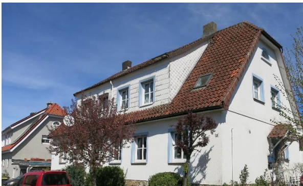
Satteldach mit Krüppelwalm und Schleppgaube
