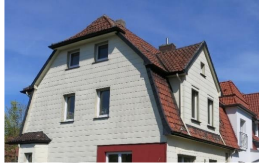
Mansardendach mit Krüppelwalm und Dachaufbau mit Giebelgaube
